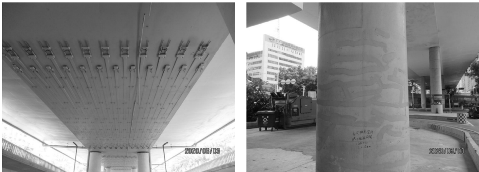
图 11 深圳某高架简支梁桥
